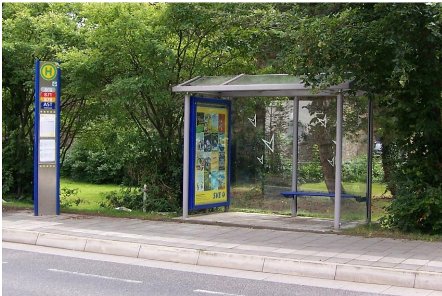
SVE-Haltestelle mit erhöhtem Bordstein, Blindenleitsystem, Haltestellensäule und Wartehalle
